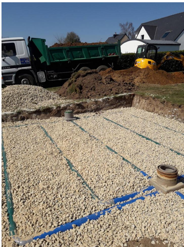
Figure 2 : Filtre à sable vertical non drainé contrôlé avant remblaiement
